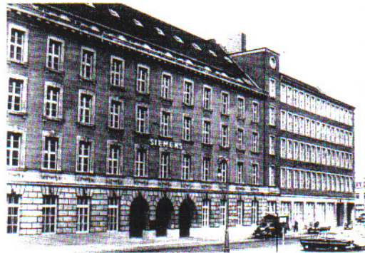
Siemenshöfe Berlin-Mitte, Schöneberger Str. 2-4, vor Umbau und Sanierung.
